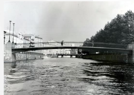
Завершено строительство моста 1969 г.
