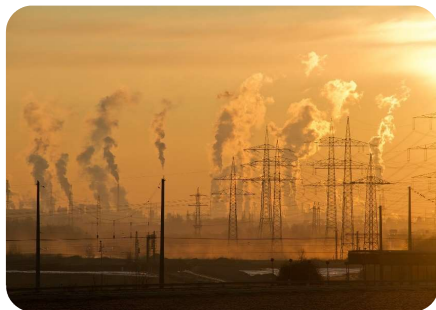
Зоны с коррозионной средой
