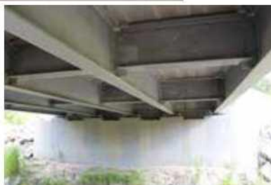
Вид на мост снизу: диафрагма и оцинкованные балки
