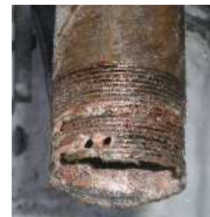
Сталь с цинковым покрытием НКТ 73x5,5 175 суток
