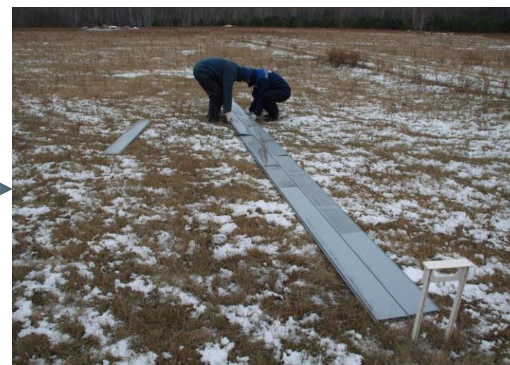
ПЛИТЫ СОБИРАЮТСЯ ВРУЧНУЮ БЕЗ КАКОЙ-ЛИБО ТЯЖЕЛОЙ СПЕЦ. ТЕХНИКИ
