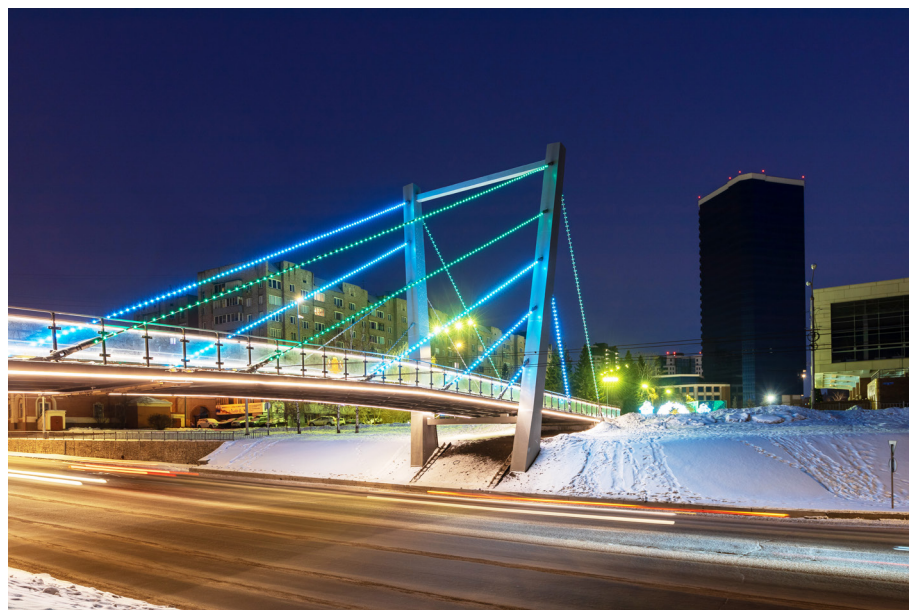
Первый в России вантовый мост из алюминиевых сплавов (Красноярск)
