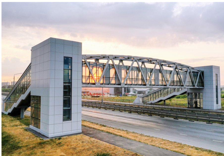
Первый в ЦФО надземный пешеходный переход с конструкциями из алюминиевых сплавов (Тула)
